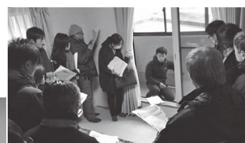
▲バルコニーの調査
